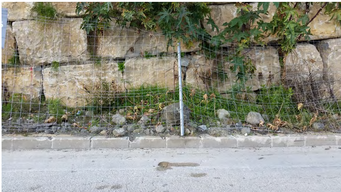
Foto 5. Aceras de viales ocupadas por vallas y restos ocultando posibles hidrantes.
