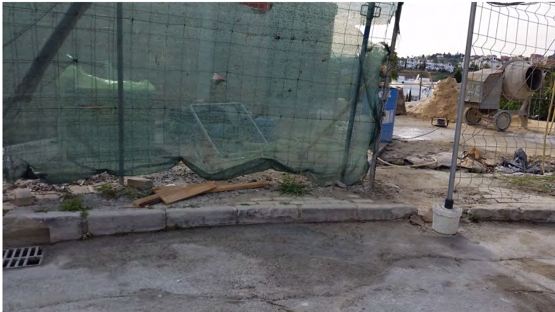
Foto 2. Aceras de viales ocupadas por obras ocultando posibles hidrantes.
