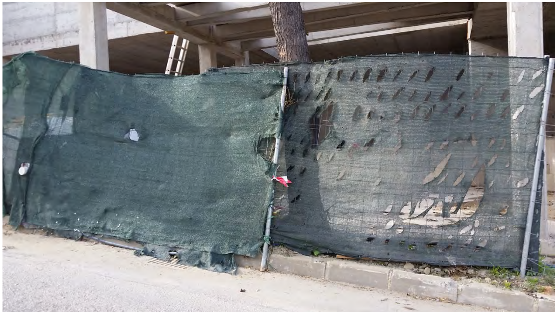
Foto 4. Aceras de viales ocupadas por obras ocultando posibles hidrantes.
